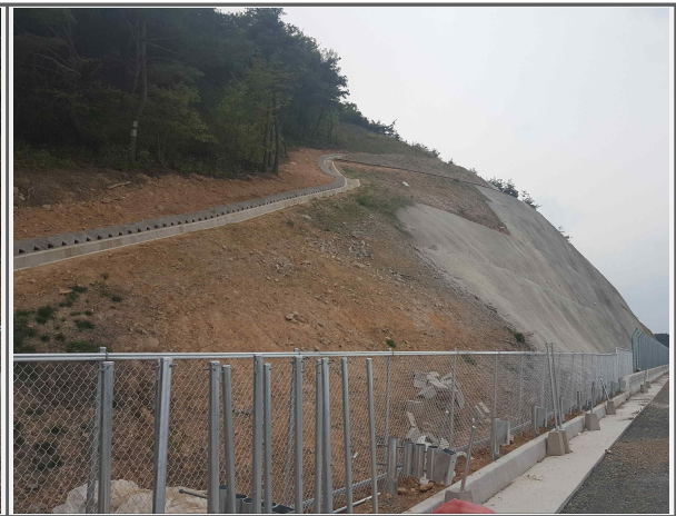
② 절토사면 시공 현황(중점 횡단)
